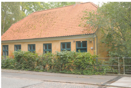
Møllehuset ligger helt op til slusen i Frederiksdal. Foto: Jan Carlson
