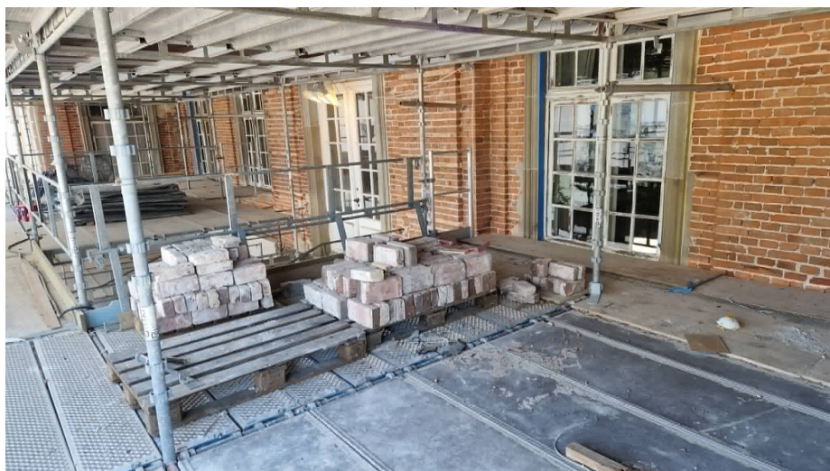
Her ses det originale murværk på slottet, inden det igen hvidkalkes.
