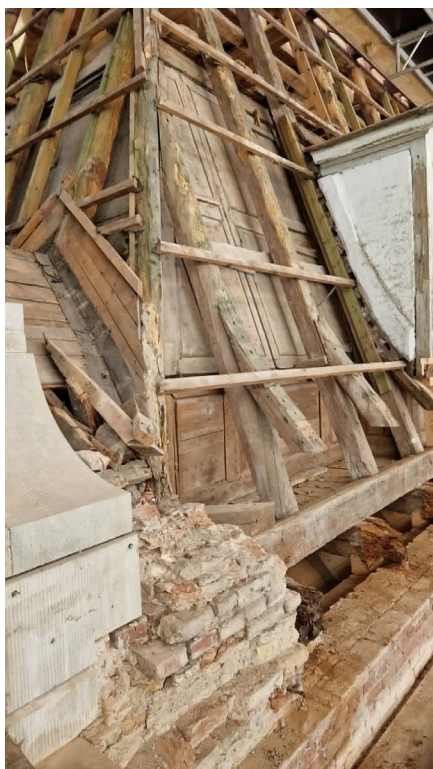
Både sten og tømmer gennemgås grundigt og udskiftes om nødvendigt
